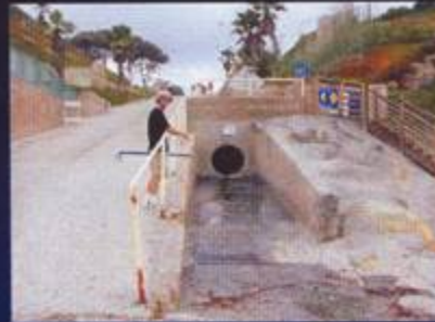
6sz: Storm drain
