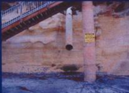
4sz: Storm drain
