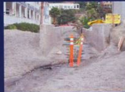
-4sz: Storm drain
